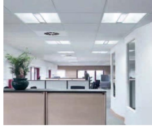
شكل (3.5): الناشر في جهاز الانارة يعطي هنا ضوء مباشر منتشر ( جهاز فلورسنت ذو الناشر)
