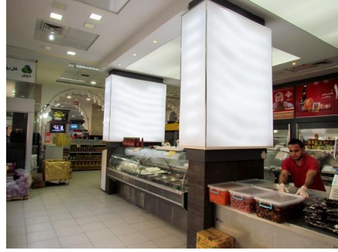
لقطة تظهر اعمدة مكسوة بالاضاءة ( نوع حبل زينة 50ملم*50ملم ابيض اللون نوع ليد مخفى داخل ناشر بلاستيك )
