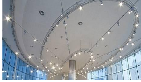
شكل (3.66): إمالة جهاز الانارة بزاوية اعلى من 30 قد يحدث وهج
