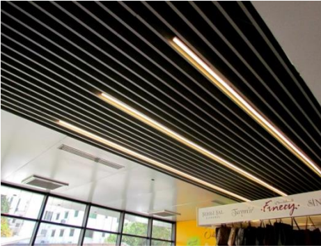
جهاز انارة خطي نوع ليد لون اصفر يتوسط شرائح الالمونيوم ضمن تصميم السقف
