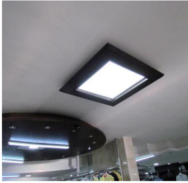
وحدات اضاءة نوع ليد 60ملم*60ملم ذات ضوء متمائيل استخدم للانارة العامة
