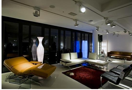
شكل (3.65): جهاز سبوت لايت معلق على السكك غاطسة في السقف لانارة مركزة
