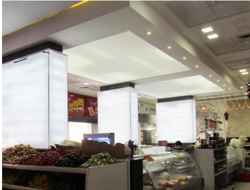
السقف المضيء luminous Ceiling وهو للحصول على اضاءة منتشرة حيث أن السقف بأكمله يعتبر كوحدة إضاءة واحدة حيث توضع وحدات الإضاءة خلف سقف مستعار من خامة ناشرة للضوء
