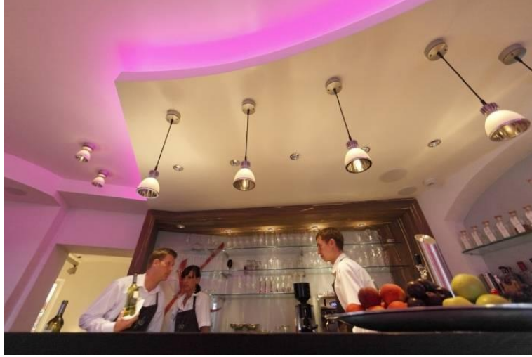
شكل (3.56): صورة لجهاز داون لايت صغير الحجم نو المصباح الهالوجين متدلي من السقف
