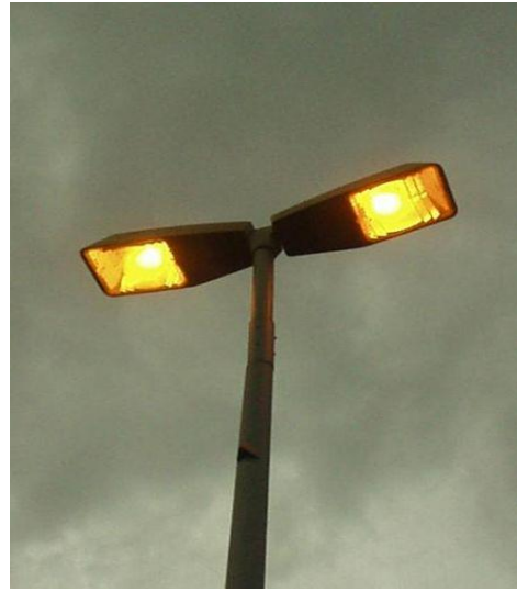
شكل (2.24): مصابيح إنارة للشوارع من بخار الصوديوم، المصدر: (ويكيبيديا، 2018م).
